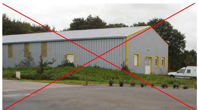
Percements standards avec ouvrants à la française, bardage translucide intégré, toiture non dissimulée par l'acrotère
