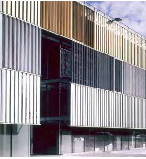
Doubles peaux métal ou bois > rôle thermique et architectural
