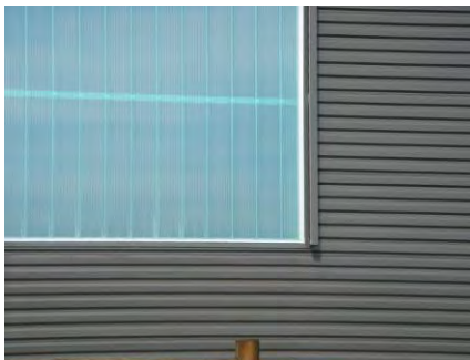
Bardage « petites nervures » / vitrage opaque en réglite
