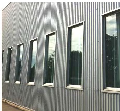
Bardage acier Fréquence 13.18 (petites ondes)
