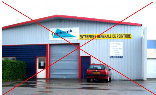
Enseigne dépassant de la ligne de toiture / Multiplication des informations, couleurs et type de texte qui nuit à la lecture
