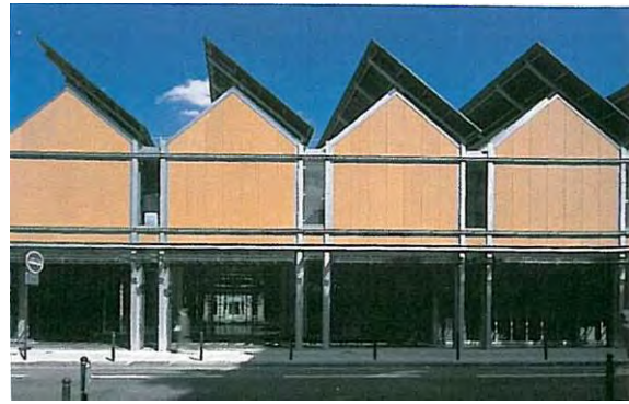
Toiture contemporaine et équipée de panneaux photovoltaïques
